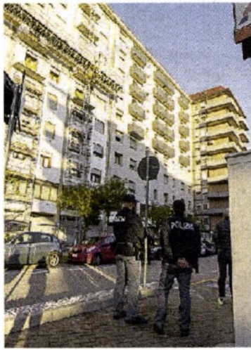
A RISCHIO Il condominio Bandiera
